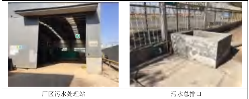
图 2.4-2 厂区现有污水站及排放口照片
