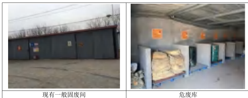
图 2.4-3 现有工程固体废物暂存设施情况
