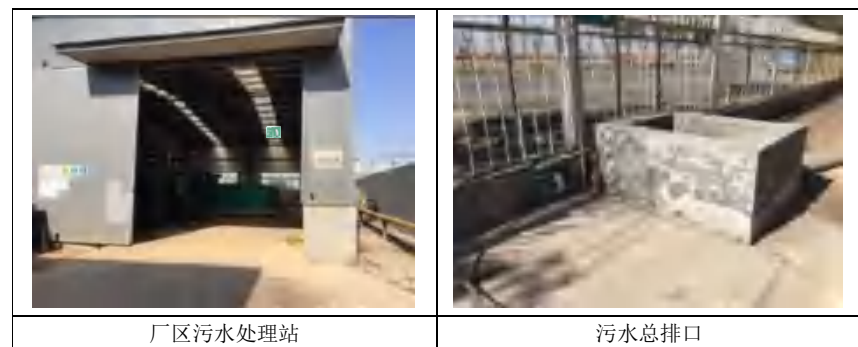
图 2.4-2 厂区现有污水站及排放口照片
